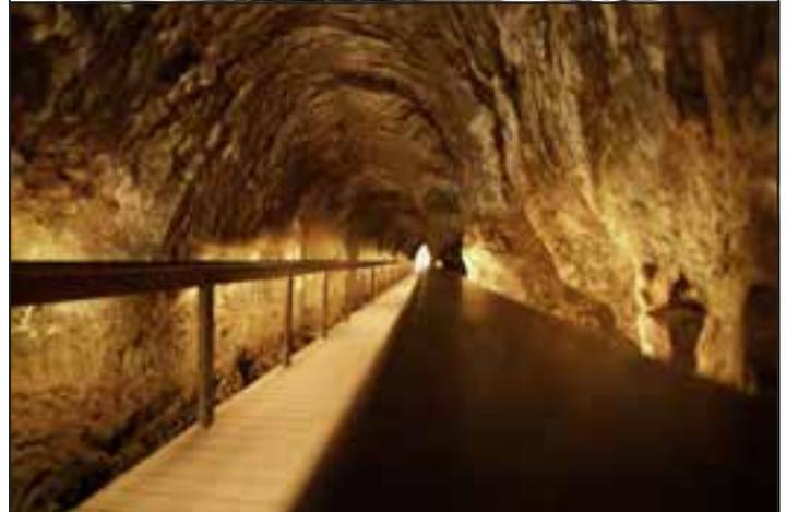
Ahabs Ingenieure trieben daher einen mächtigen Schacht fast 45 m in die Tiefe und von dessen Grund einen 70 m langen, waagrechten Tunnel bis zur Quellschale. Zur Sicherheit verschlossen sie die Öffnung der Quellschale nach außen. Schacht und Tunnel sind über Treppen und Stege für Besucher zugänglich und lohnen auf jeden Fall einen Besuch!
