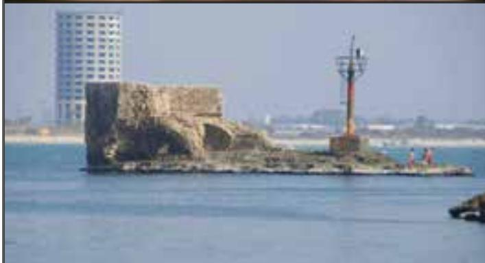
hundreds beauftragte der ägyptische Herrscher Ahmad ibn Tulun den Architekten Abu Bekr al-Bana' mit der Erweiterung des Hafens. Der mit Steinlagen auf Sykomoren-Bohlen ausgebaute Hafen hatte eine große Bedeutung für den Handel im Mittelmeer. Die Einfahrt wurde nachts durch Ketten verschlossen.
