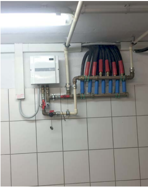
Abbildung 53: In potenziell überfluteten Bereichen sollten die Installationen möglichst hoch über dem Fußboden angebracht werden. Als Wandverkleidung haben sich Fliesen bewährt.
