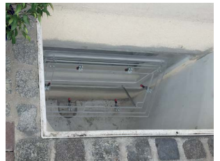
Abbildung 58: Wasserdicht verschließbares Kellerfenster.
