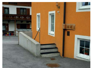
Abbildung 59: Nachträglich durch Aufmauerung geschützter Kellertreppenzugang.
