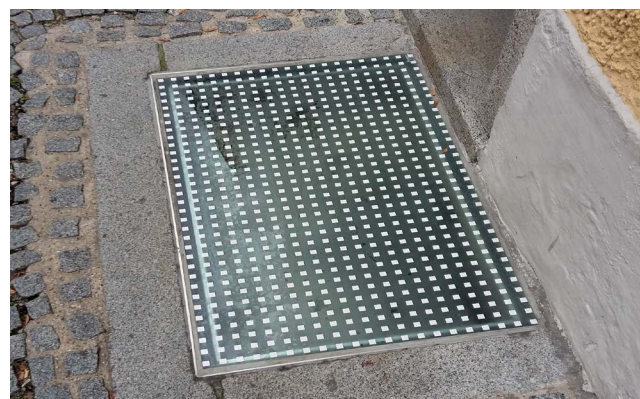
Abbildung 36: Abgedichteter Lichtschacht.
