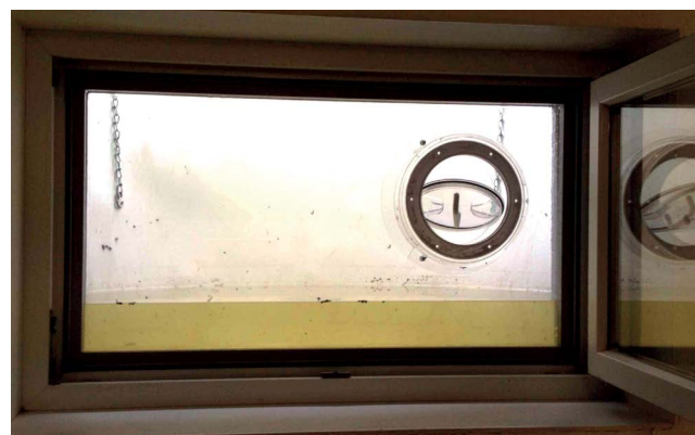
Abbildung 35: Fensterschott mit Lüftungsöffnung.
