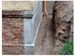
Abbildung 63: Nachträgliche Abdichtung mit wasserdichtem Sperrputz.
