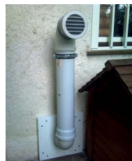
Lüftungsöffnung über Hochwasser- niveau
